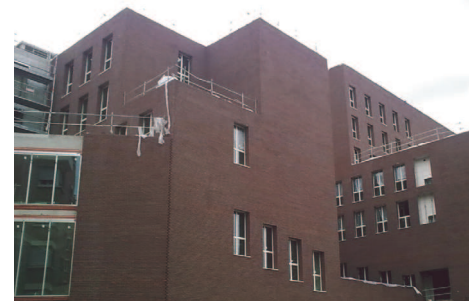
CI-DESSUS Le bâtiment en construction, côté rue Cantagrel, août 2010.
